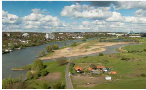
WIDENED RIVER: FLOODPLAIN EXCAVATION MEINERSWIJK, NL ( https://www.ruimtevoorderivier.nl/project/uterwaardvergraving-meinerswijk/ )
