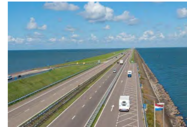
Afsluitdijk, NL image: https://www.renovatieprofs.nl/images/article/medium/5502e1bd03746.jpg
